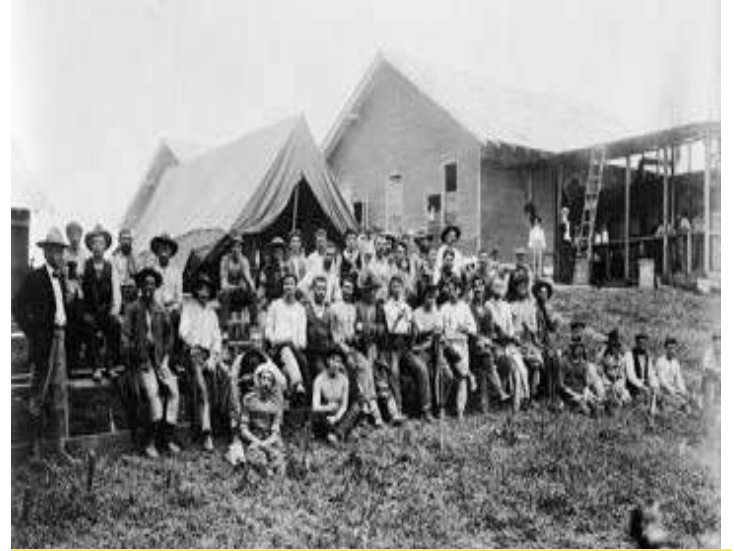
Panama Kanalı inşasında çalışan bir grup işçi
